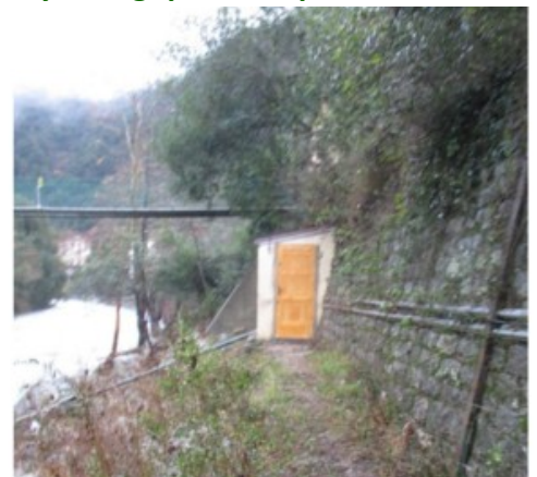
Station hydrométrique de Breil-sur-Roya avant la tempête Alex (septembre-octobre 2020)
