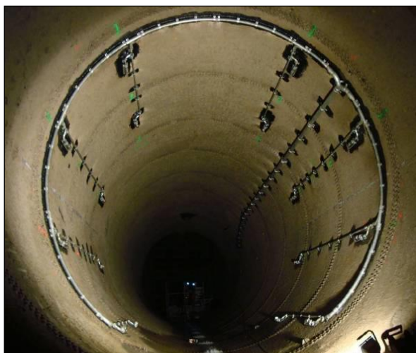
Figure 13. Capteurs US, conduite de l'usine de Génissiat
